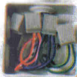
Connexion par bornes de raccordement par enchâssement.
